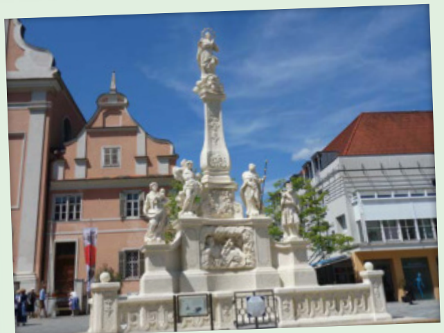
Die Mariensäule erstrahlt nach der Renovierung in neuem Glanz.
